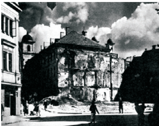
Pusty plac po zburzonej kamienicy na rogu ul. Ostrobramskiej 2 i ul. Subocz, (Źródło: https://istorijos14.rssing.com/channel-63548356/all_p10.html )
